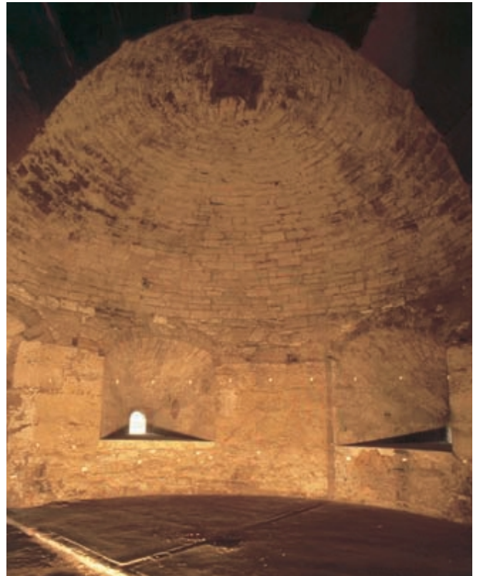
Erdgeschoß des Turmes mit Kanonenscharten und Rauchabzugsloch.
