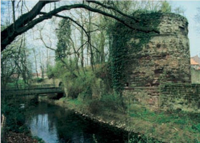
Der Mühlenkanal quert mit Hilfe eines Wasserkastens das tiefer liegende Krumme Wasser in der Nähe des Diek-Turms.
