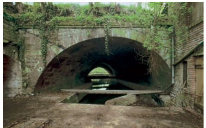
Durchfluß des Mühlenkanals unter dem Wall am Diek-Turm, Ansicht von der Stadtseite.
