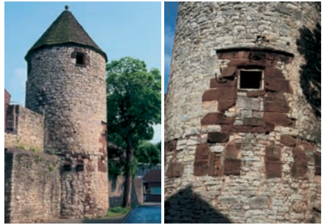
Pulverturm im Sonnenhaken, Hocheingang mit abgeschlagenen Kragsteinen des Wehanges und Inschriftensteinen.
