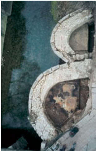
Aufsicht auf die erhaltenen Mauerzüge der Oberen Katze. Im Inneren Niveau zur Zeit des Stadtbrandes von 1540.
